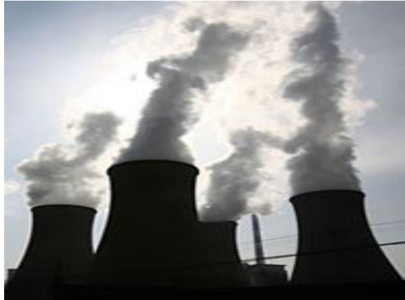
Elektrik Güç Santrallerinin Soğutma Kuleleri
